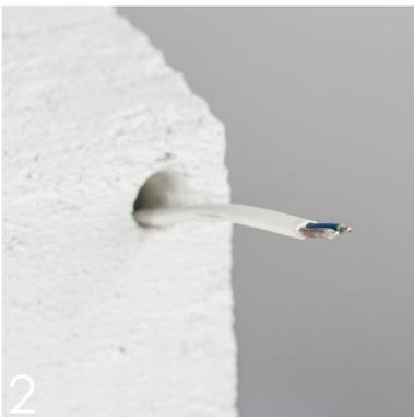
Kabel durch das Loch führen
