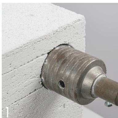
Mit 60 mm Dosenbohrer, ca. 455mm tief bohren,, 20mm Abstand vom Rand zur Treppenkante.
