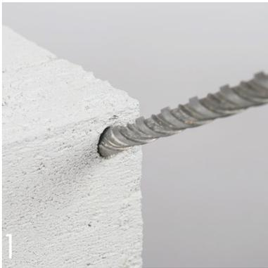
Loch mit ca. 20mm Abstand zu den Stufenkanten bohren.
