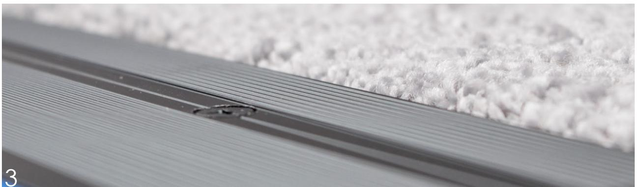
Bei einem richtig angeschraubten Profil, sind alle Schrauben bündig zur Oberfläche. Das Profil sitzt fest an der Treppenkante.
